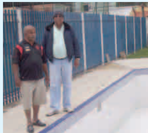
O presidente Buda e o vice Nazareno vistoriando as obras de reforma da Sede Social. As piscinas foram totalmente remodeladas e já estão prontas.
