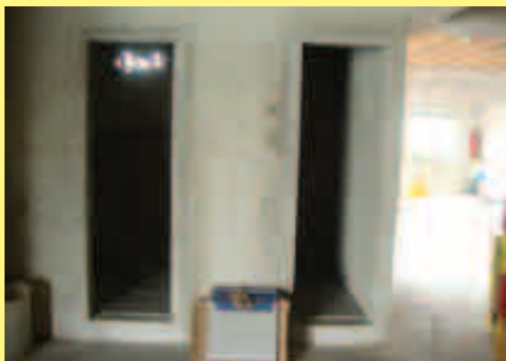
Todos os sanitários da Sede foram reformados e alguns novos foram construídos.
