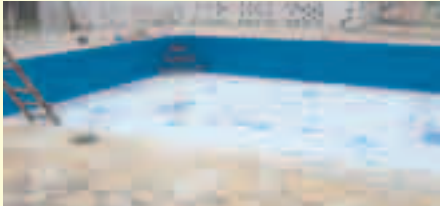
A enorme piscina de água corrente está sendo totalmente reformada
